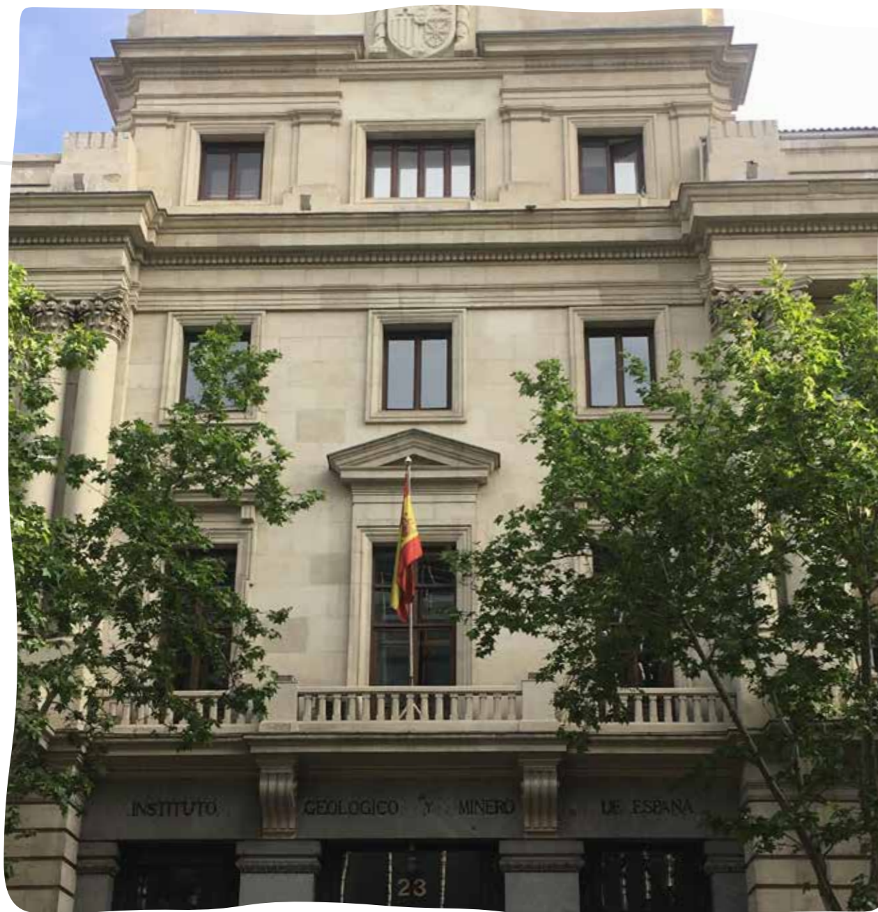
FACHADA DE LA SEDE CENTRAL DEL IGME. FUENTE: IGME
